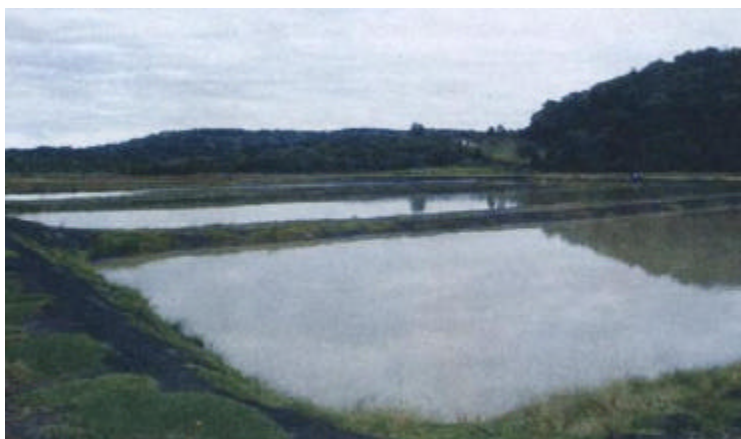
Figura 3: Estanques excavados en tierra
